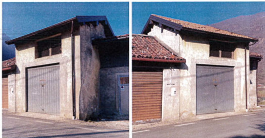
VISTA DA VIA S. PELLICO
