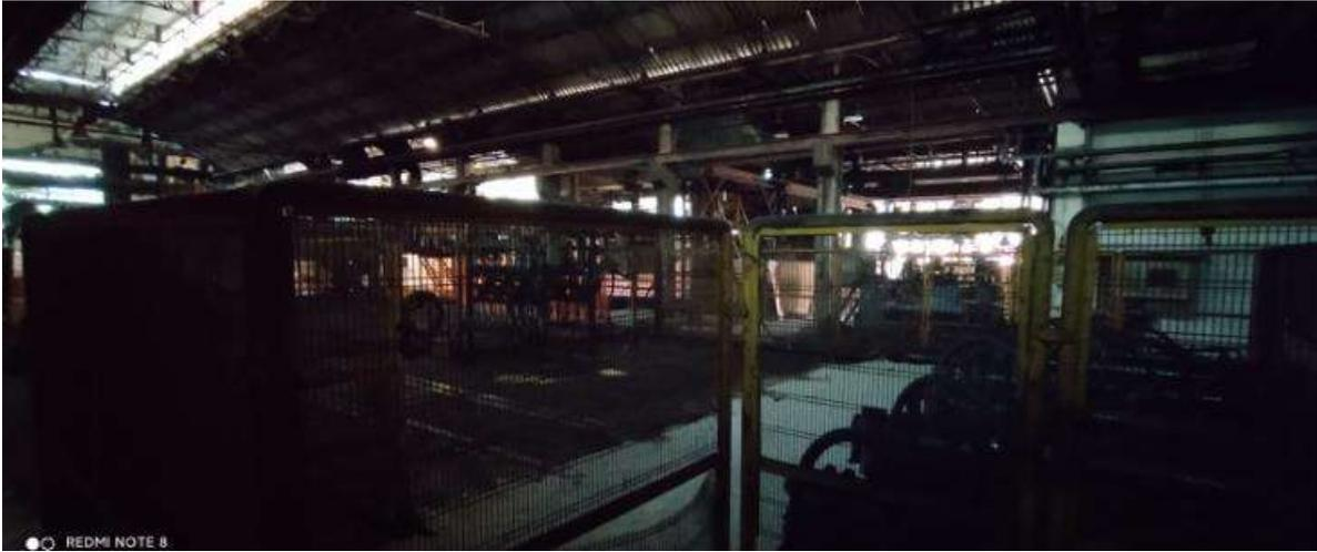
La copertura a tetto curvo in ferro del capannone è rivestita da lastre di cemento-amianto.
