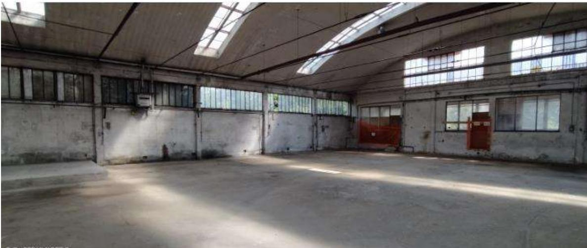
Doppio Magazzino prodotti finiti con tetto curvo in cemento armato
